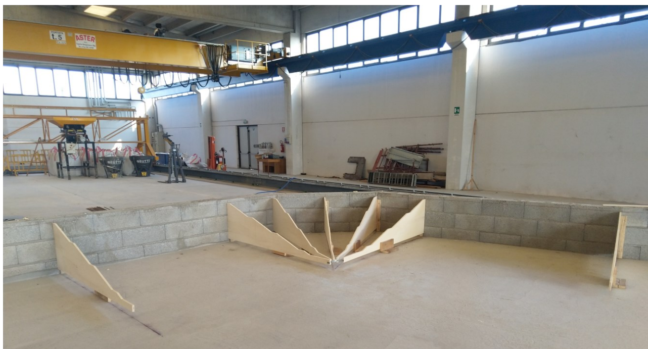
Figura 2-13 - Posa delle centine. Sono visibili le tracce per il corretto posizionamento planimetrico.
