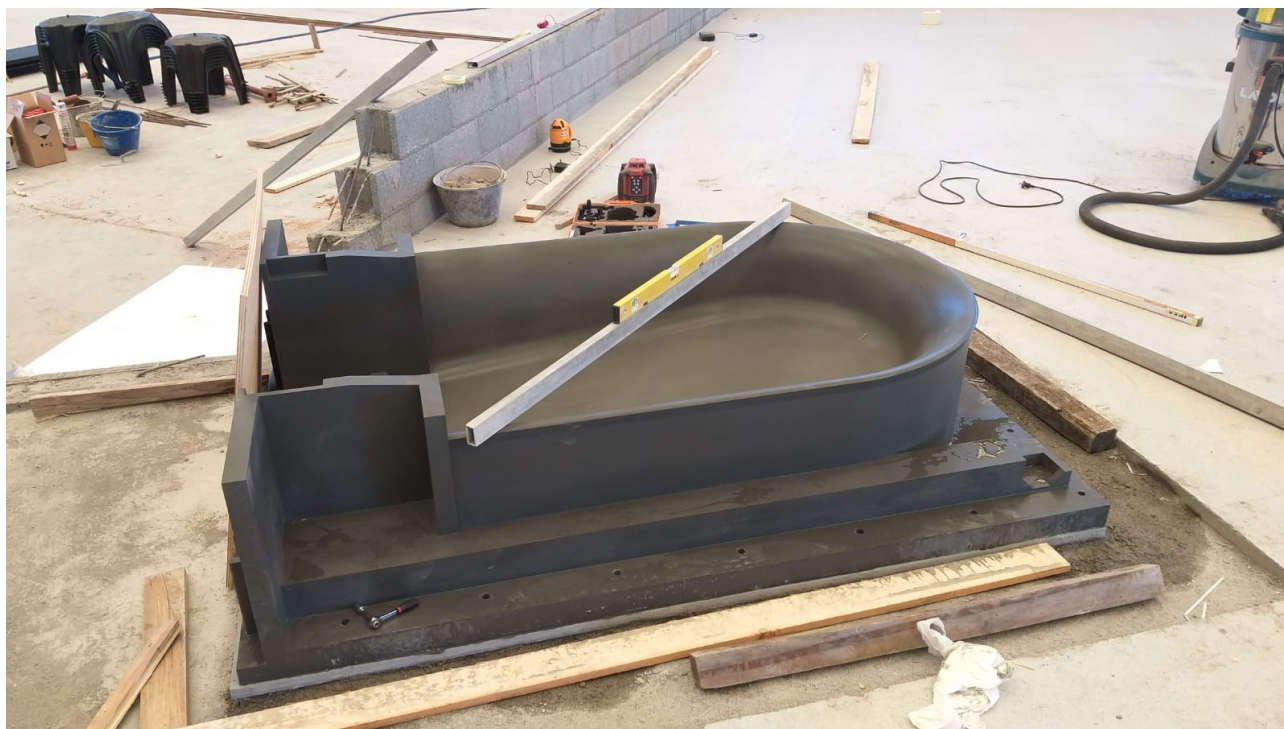
Figura 2-9 - Posa del manufatto C con l'ausilio di una livella per garantire l'orizzontalità.
