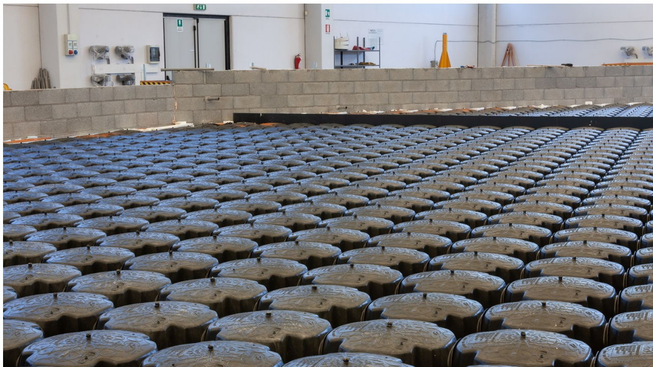
Figura 2-5 - Vista del riempimento con igloo prima della posa in opera della rete elettrosaldada e dello strato di calcestruzzo.
