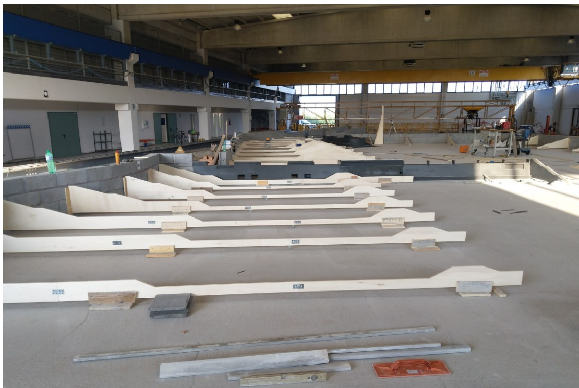
Figura 2-14 - Posa delle centine per la sagomatura dell'alveo e degli argini.
