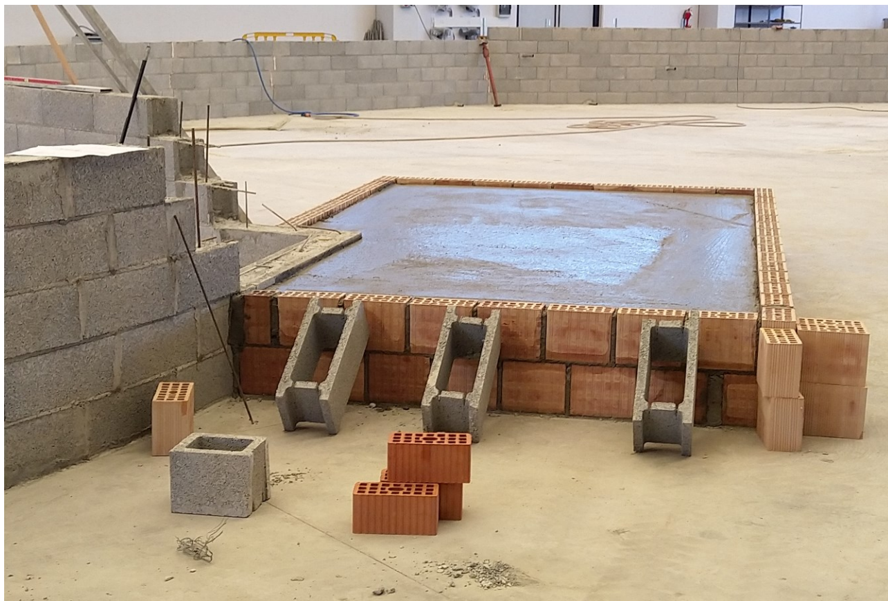
Figura 2-8 - Soletta in calcestruzzo per il posizionamento del manufatto C.
