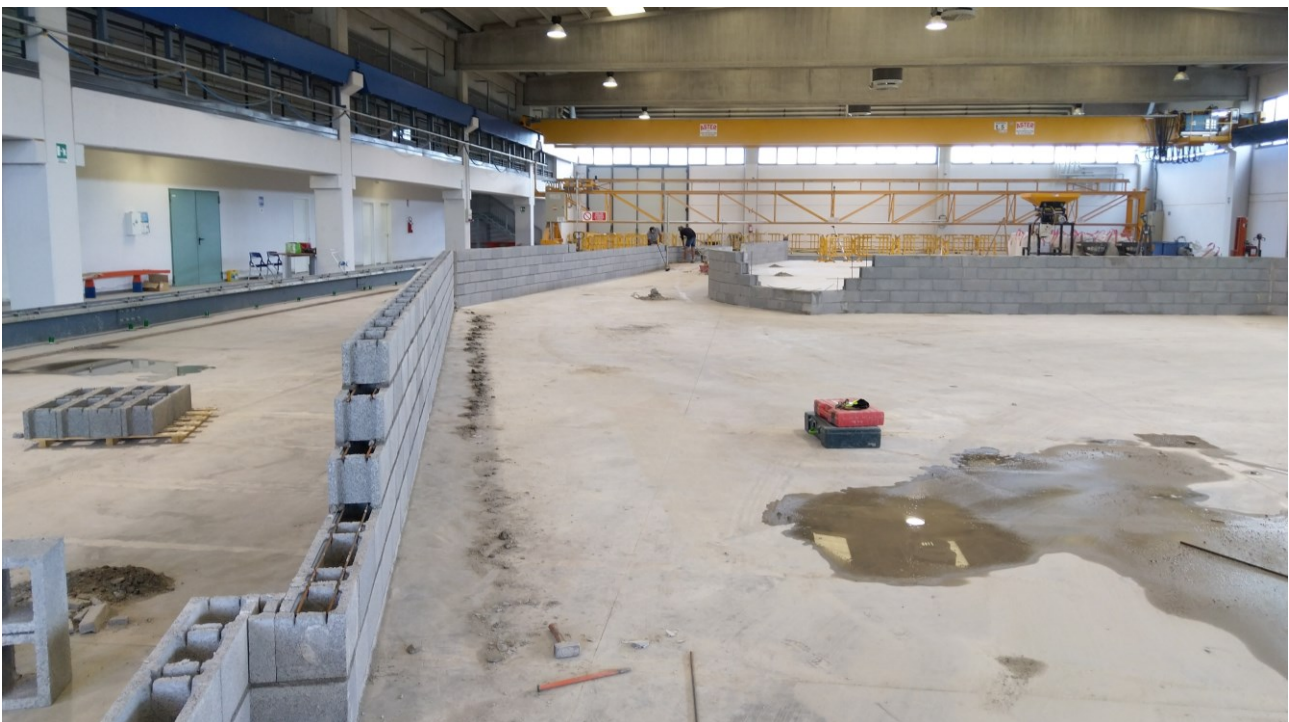
Figura 2-4 - Un momento delle fasi di posa delle opere murarie.
