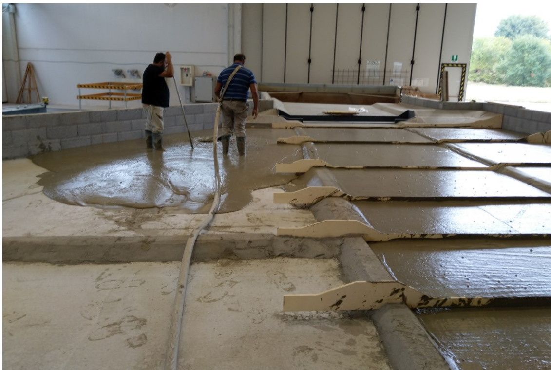
Figura 2-16 - Riempimento con cemento alleggerito – cassa di monte.
